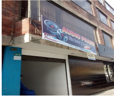
Fotografía No. 2: Aviso volado/saliente de fachada del establecimiento Audio Prado, Ubicado en la Calle 131 No. 45 - 10 Registro fotográfico, Visita No. 2 efectuada el día 26/05/2015
